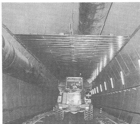
写真-5 天井隔壁設置状況
