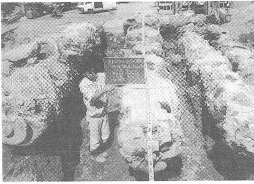
写真-2 造成体出来形（礫混り土地盤：千葉富津）
