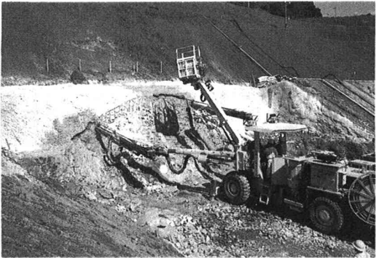
写真-1 施工状況
