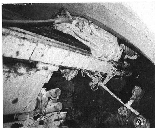
写真-2 プレライニング施工状況
