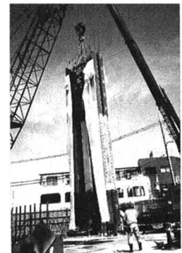
写真-2 鉄筋籠建込
