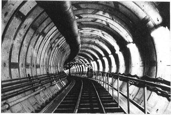
写真-3 NMセグメント覆工仕上がり状況
