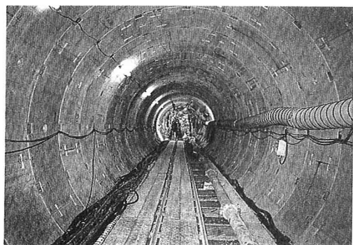
写真-5 トンネル内状況
