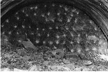
写真-4 発破終了後切羽状況
