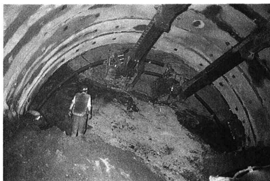
写真-5 ガントリージャンボによる支保工建込
