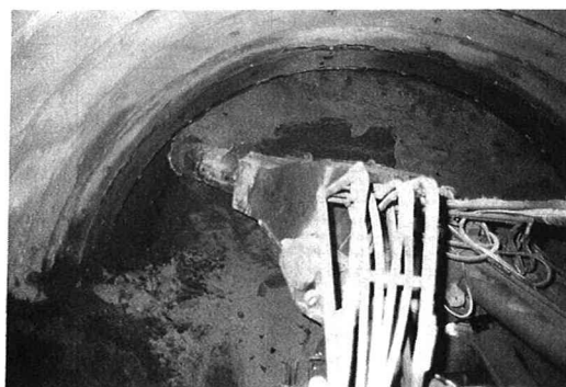
写真-4 自由断面掘削機による掘削状況
