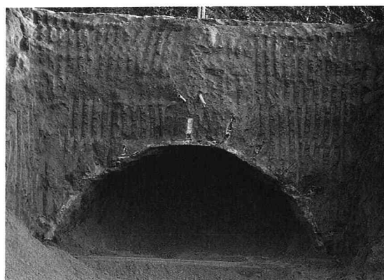
写真-2 プレライニングトンネルの掘削
