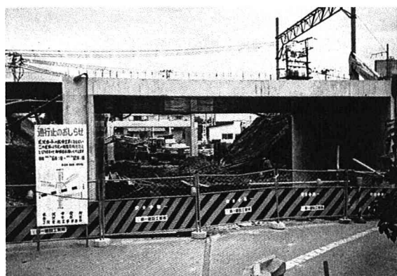
写真-2 施工状況（掘削作業）
