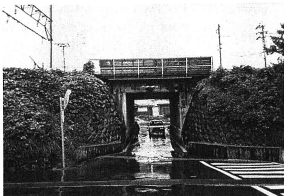
写真-1 既設架道橋の現状
