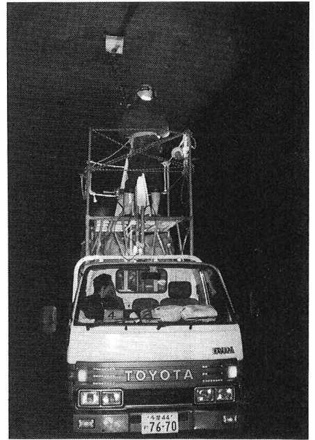
写真－１ 調査状況
