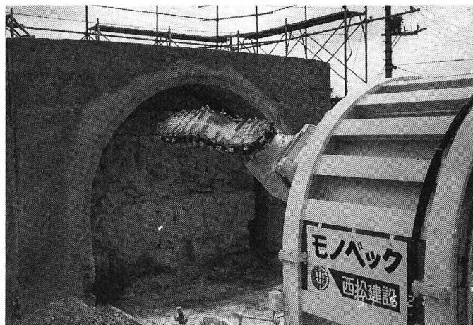
写真-4 スリット切削状況
