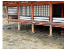
写真-2 回廊部 東柱
