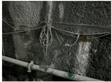
写真-3 坑内の壁面
