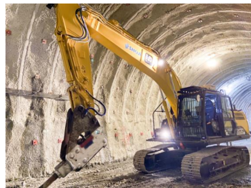
写真-1 改造対象の無人化施工対応バックホウ
