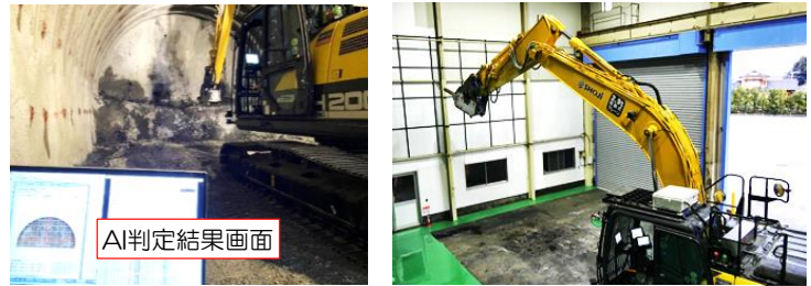
写真-5 自動コソク作業状況(左:坑内 右:工場)
