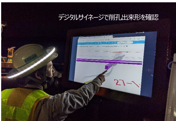
図-9 削孔位置から離れた場所で削孔出来形を確認
