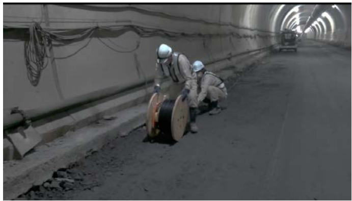
写真-2 移動時(セントル移設時)
