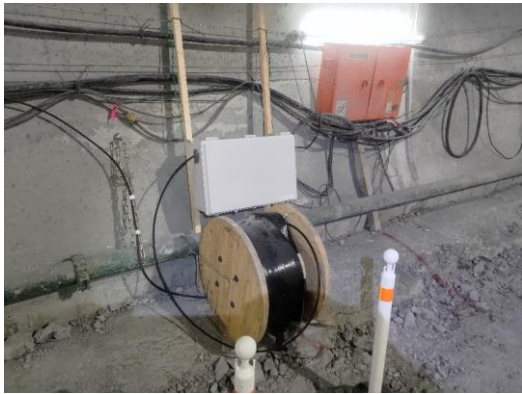
写真-1 設置状況
