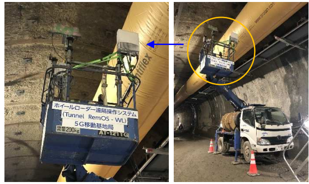
図-5 坑内固定ユニット(L5G)設置状況
