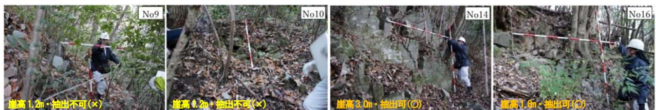
図-7 落石発生源の現況写真 9) (一部抜粋・加筆)
