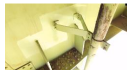
③排水管のボルトの脱落 (左: UAV 点検 右: 目視点検)
