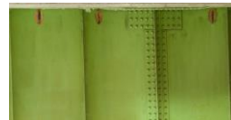
①主桁の腐食 (左: UAV 点検 右: 目視点検)
