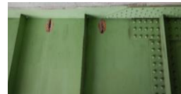
①主桁の腐食 (左: UAV 点検 右: 目視点検)
