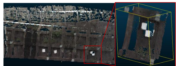
図-1 法面のレーザ点群データ
