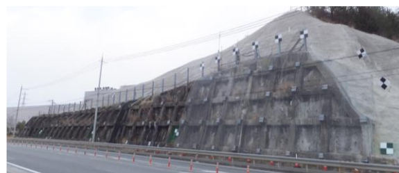
図-3 計測対象とした法枠付き法面
