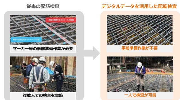
図-1 従来の配筋検査との比較
