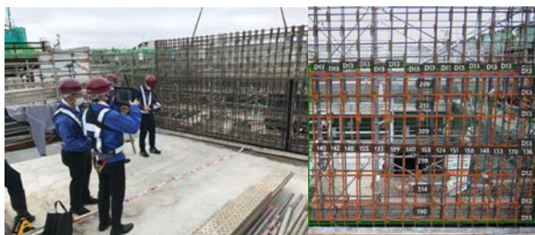
図-10 離れた箇所からの計測の様子と出力
