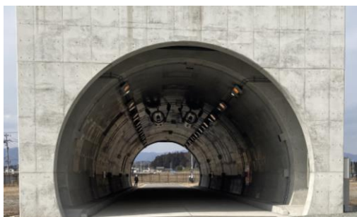
図-1 トンネル全景
