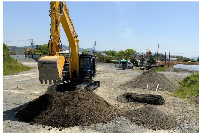
図-6 バックホウの掘削作業状況
