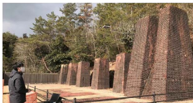
図-6 堀家製錬所跡での実験の様子
