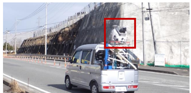
図-1 MMS が法面を計測している様子 (赤枠内が点群を取得するレーザスキャナ設置箇所)
