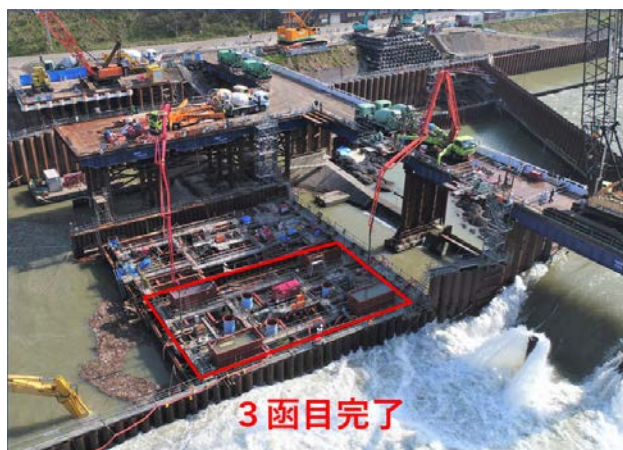
図-2 鋼製函体3 函目沈設
