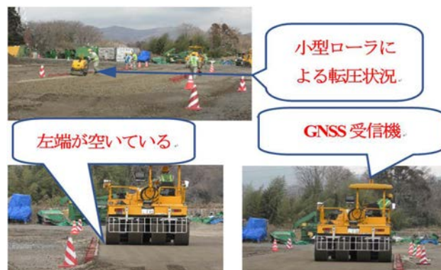
図-3 試験施工の転圧状況
