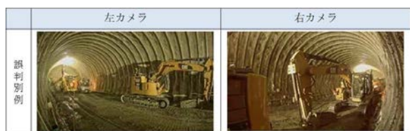
図-4 右カメラ前への待機重機の影響による誤判別例
