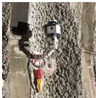
図-2 センサとセンサ設置状況
