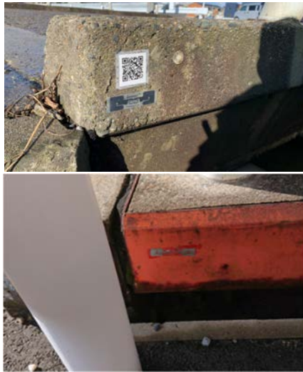
図-6 橋梁に貼付した RFID と QR コード
