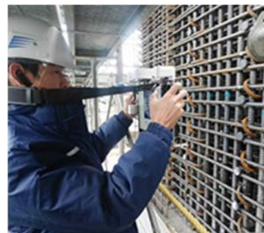
写真 10 検査状況（川崎臨港）
