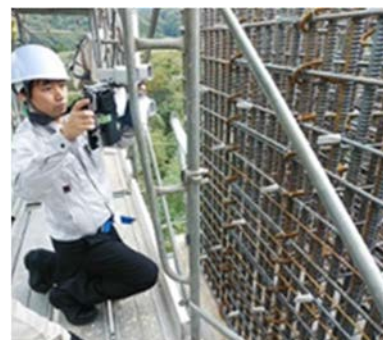
写真 9 検査状況（妙高大橋）
