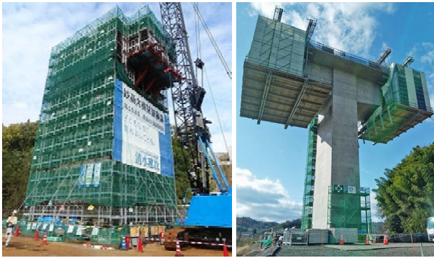
写真3 試行現場の例 (左:妙高大橋, 右:東根川橋)
