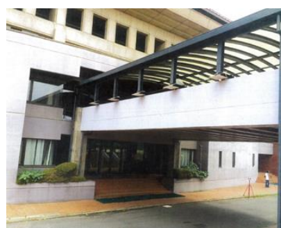
図-2 ターゲットの設置状況
