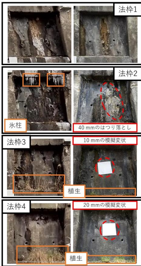
図-7 法面に与えた模擬変状の2時期の様子
