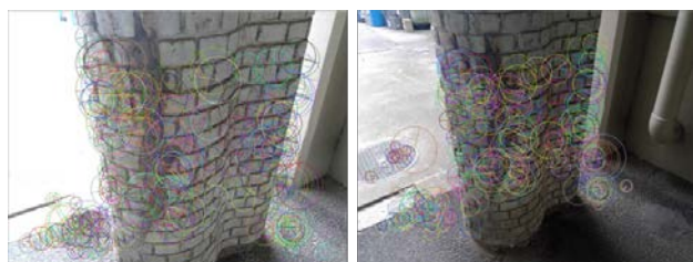
図-9 曲面形状の柱の特徴点対応結果
