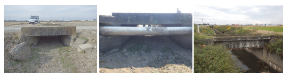
対象橋梁(橋梁 1/橋梁 2/橋梁 3)
