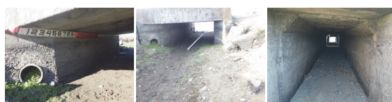
桁下状況(橋梁 1/橋梁 2/橋梁 3)
