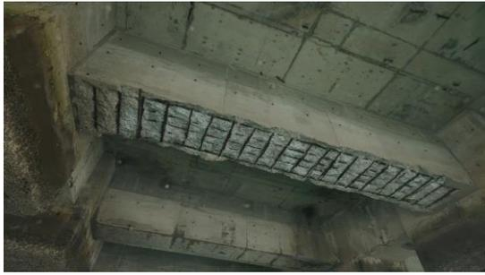
図-1 栈橋のコンクリートの剥落の例
