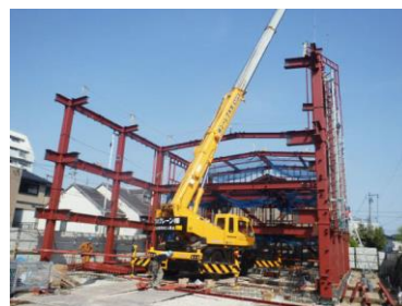
(a) 入力した施工現場画像
