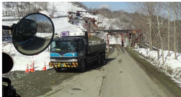
図-2 新桂沢ダムの原石運搬道路
