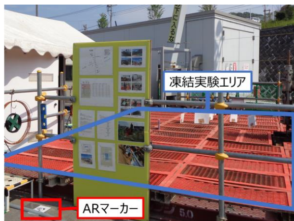
図-7 地盤凍結実験場ARマーカー設置位置
