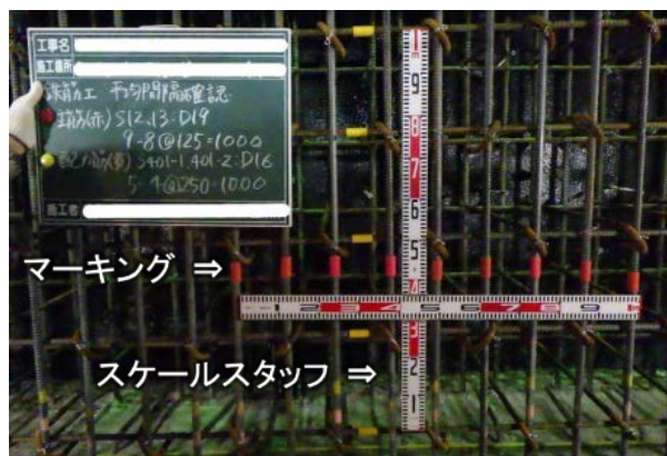
図-1 従来の配筋検査イメージ
