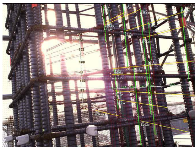
図-9 鉄道工事現場における検証（逆光のケース）
