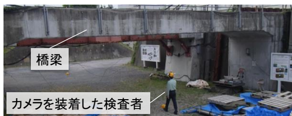
図-1 対象構造物と検査状況
