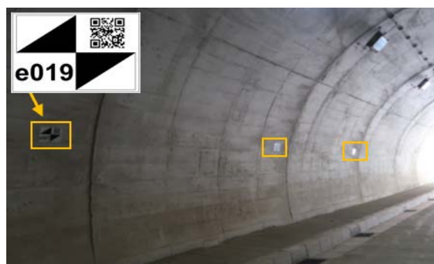
図-3 覆工マーカー設置
