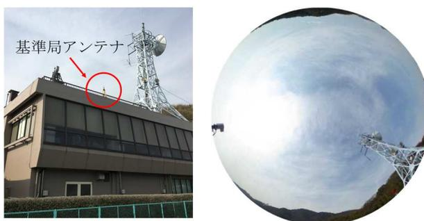
図-3 基準局の設置状況と上空視界
