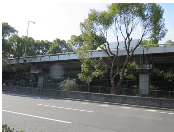
図-3 春宮跨道橋
