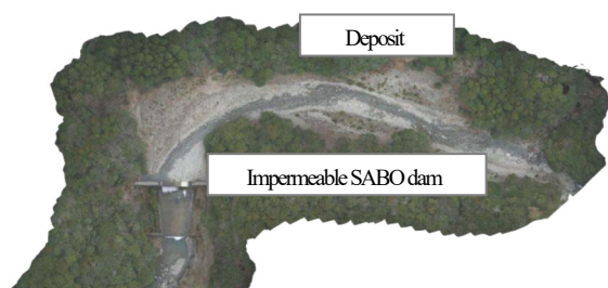
図-1 ドローン空撮機により撮影した砂防堰堤の堆砂状況の一例 5)
