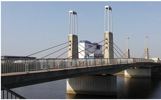
図-5 越谷市管理橋梁
