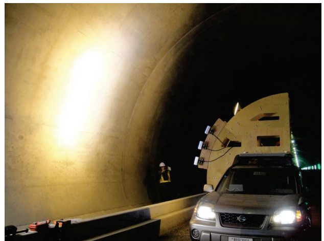
図-3 トンネルでの撮影状況
