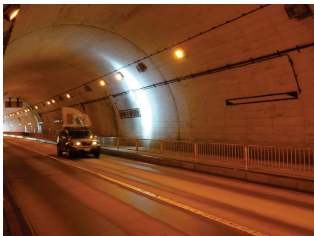
図-6 既設トンネルでの撮影状況
