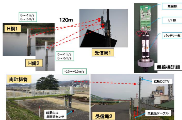
図-11 現地実験状況
