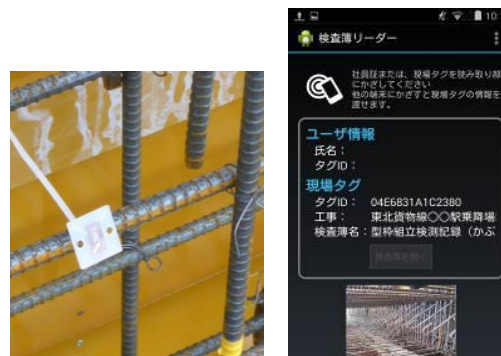
図-5 構造物管理用 IC タグと認証時の画面
