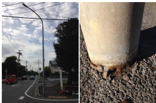
図-4 対象道路照明柱
